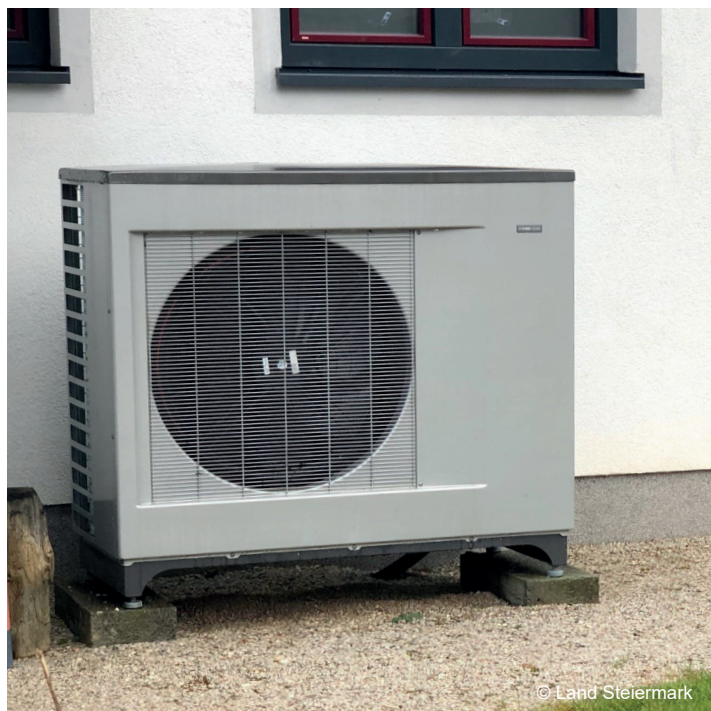
Abbildung: Wärmepumpe im Freibereich
